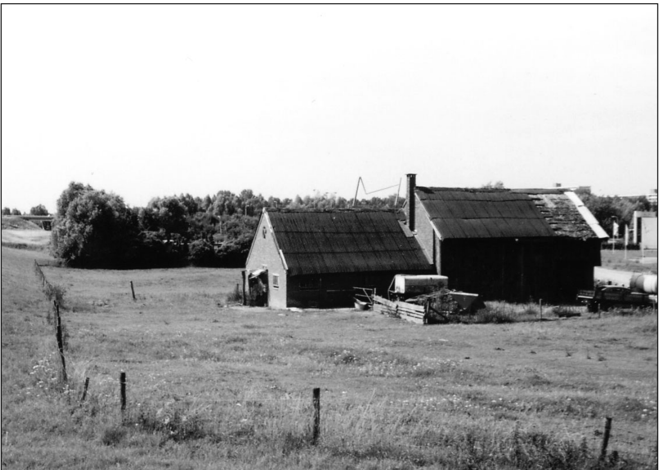
Afb. 60 De schuur van de Oude Tol vlak voor de sloop
